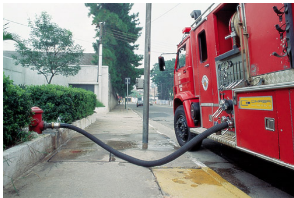
Fig. 37 – Suprimento de Água através de um hidrante urbano de coluna
