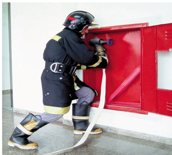
Fig. 39 – Suprimento de Água através de um hidrante predial
