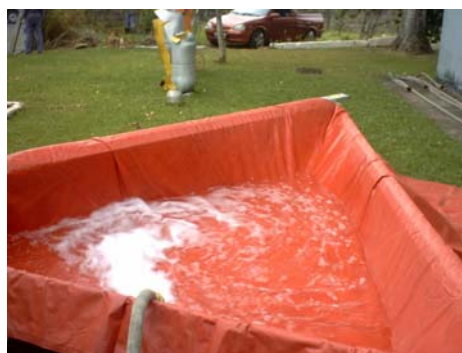
Foto 40 – Suprimento através de tanque portátil feito com escadas
